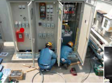
中村病院(上)、多摩丘陵病院(右)におけるキュービクル(高圧受電設備)更新工事の様子。
