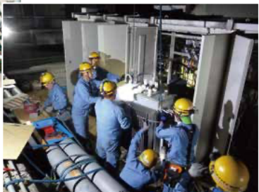
中村病院(上)、多摩丘陵病院(右)におけるキュービクル(高圧受電設備)更新工事の様子。
